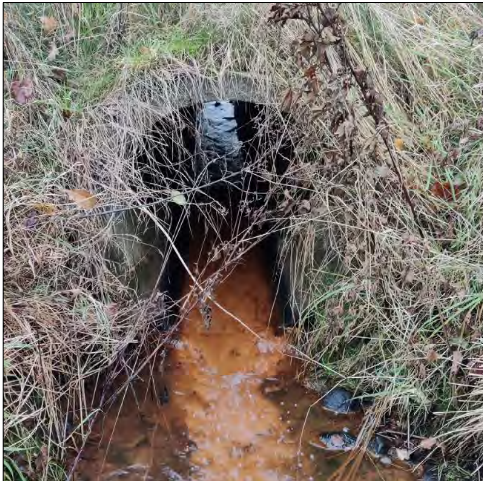
Figur 2: Udløb under markvej i st. 220 m.
